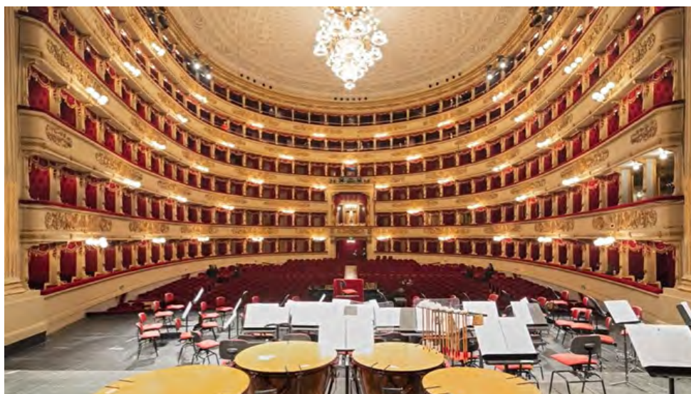
La tipica forma "all'italiana" del Teatro alla Scala: si riconoscono la platea in basso, i palchi su più livelli lungo il perimetro a forma di "U" e le gallerie nei due piani più in alto
